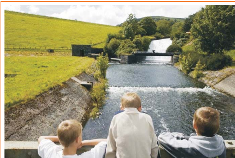
Questo è uno dei sei sistemi idroelettrici riportati in vita da The Green Valleys. L'immagine è gentilmente concessa da Stephen Shepherd.
